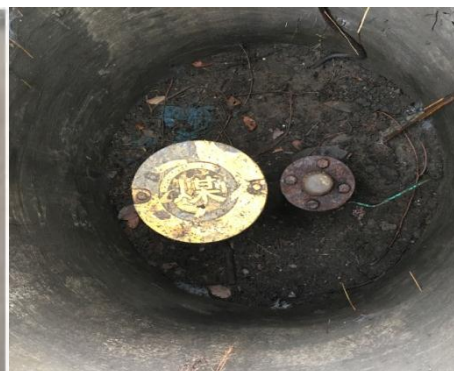
图 2-9 PE 球阀法兰放散口
