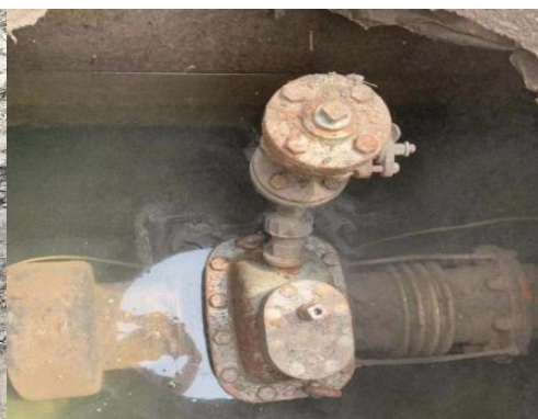
图 2-5 法兰盘连接
