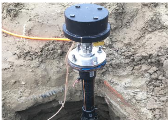
图 2-4 法兰盘连接
