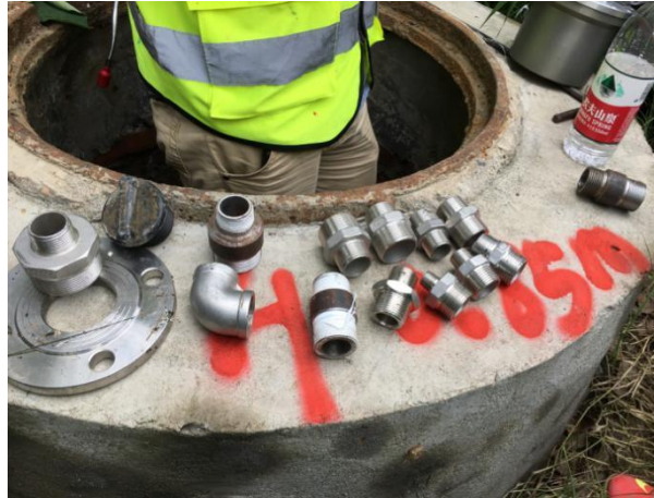
图 2-2 放散口连接工具
